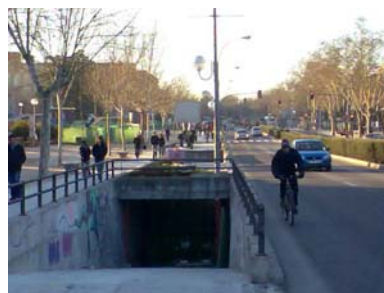
Avda. Complutense: 1. Accesos al aparcamiento subterráneo actualmente en obras de acondicionamiento; 2. Obras de ejecución del eje Moncloa-Dehesa de la Villa del Plan Director de Movilidad Ciclista
